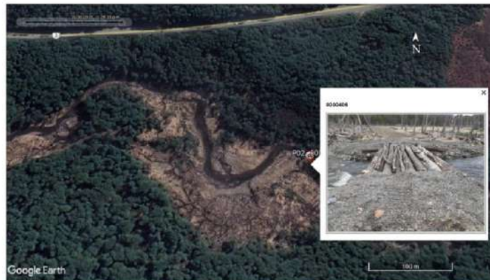
Imagen N°2: Ubicación en planta del sitio donde se encuentra construido el puente. En coordenadas geográficas Latitud 54°43'52.39"S – Longitud 67°57'58.41"O.
