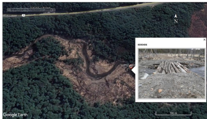
Imagen N°2: Ubicación en planta del sitio donde se encuentra construido el puente. En coordenadas geográficas Latitud 54°43'52.39"S – Longitud 67°57'58.41"O.
